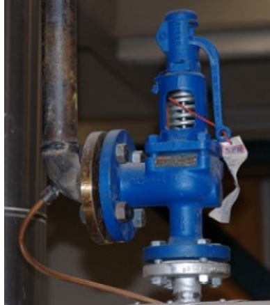
Gambar 8. Safety valve yang sudah terpasang pada peralatan Sumber https://marinersgalaxy.com/boiler-safety-valve
